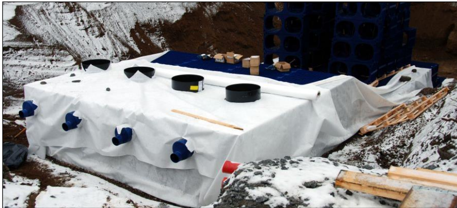
Kuva 6. Maanalaisen 300 m 3 kennoston rakentamista Tampereen Tykkitiekkadulla.
